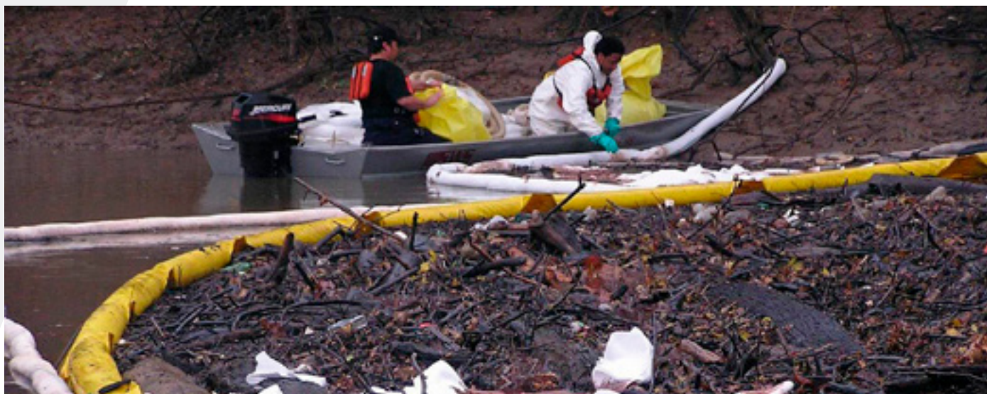
Barrera FOB, altura: 254-1067 mm (10-42 pulgadas)
